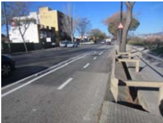
El recol·lector d'aigua no es troba correctament protegit.
