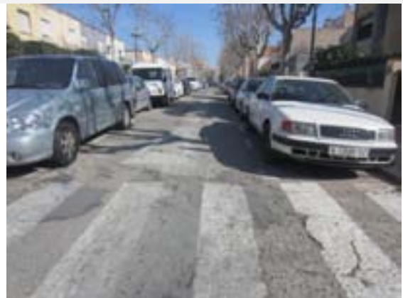
C. de Roig i Soler. Aparcament obstaculitzant la visibilitat del pas i amb l'estat del ferm defectuós.
