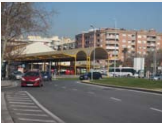
Estació d'autobusos de Reus.
