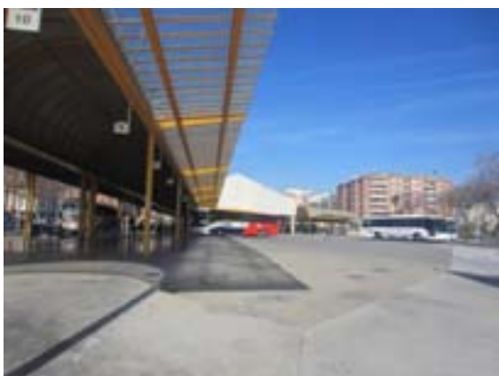
Estació d'autobusos de Reus. Avinguda de Salou.
