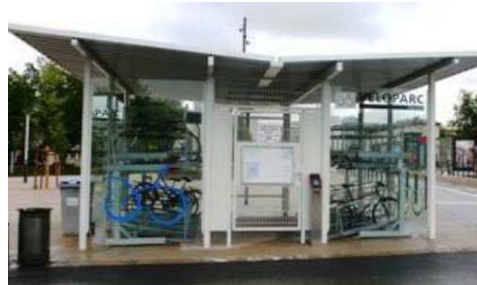
Imatge 1.1.8 "Bicibox" de l'EMT de Barcelona i aparcament cobert a una estació de tramvia d'Estrasbourg.
