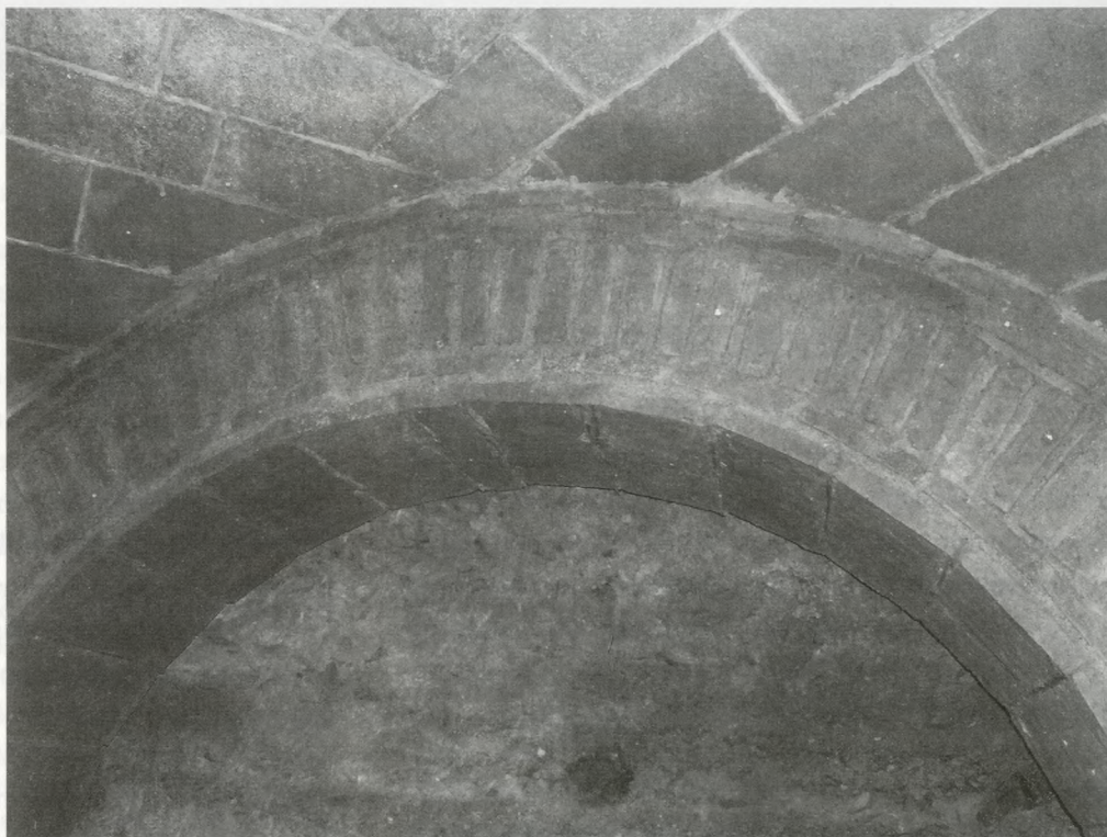
Detall de la construcció del refugi de la Patacada (Foto: AMR/E. Gort).
