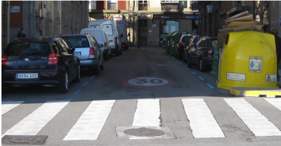
Imatge 1.2.4 Porta d'entrada a una zona 30 a Gijón. Font: Elaboració pròpia
