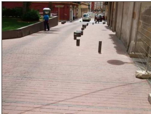
Pilones inferiors a 0,80 m al c/ Pintor Bergadà.
