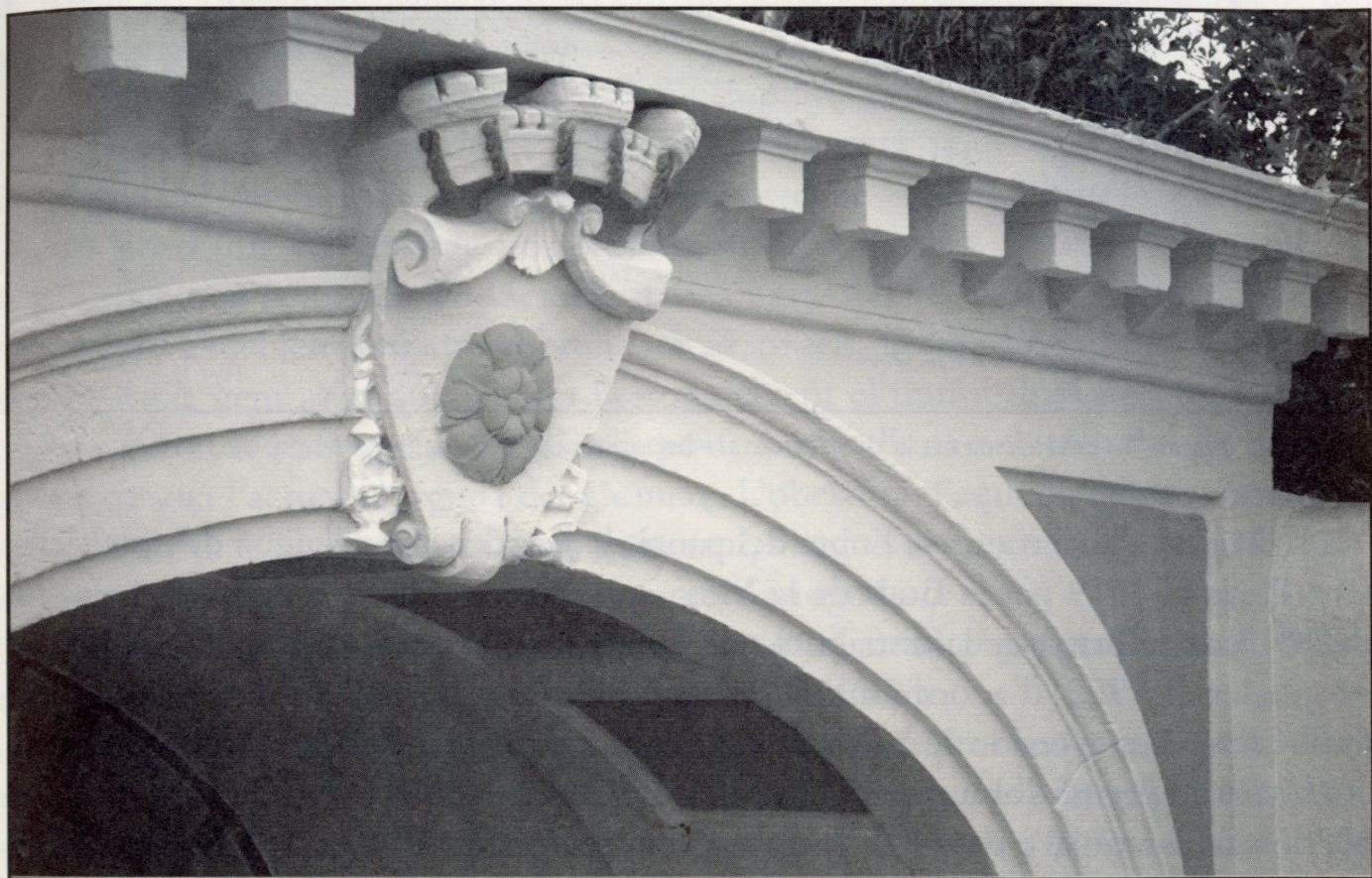
Detall de la Boca de la Mina, ja restaurada, amb l'escut de Reus ubicat a la clau d'arc, el 2009.
