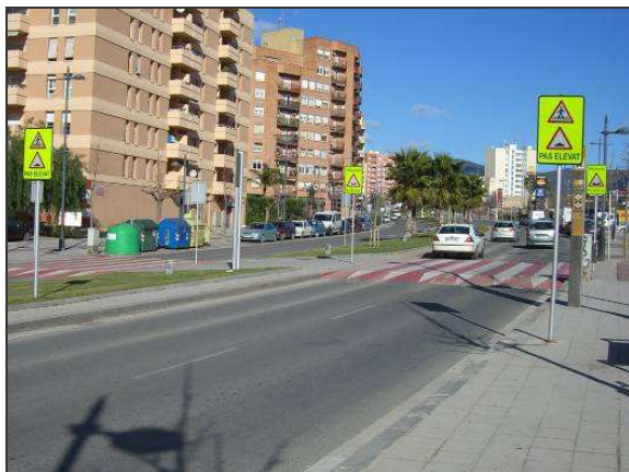
Imatge 4.1.11 Pas de vianants de ressalt a l'av. Marià Fortuny.
