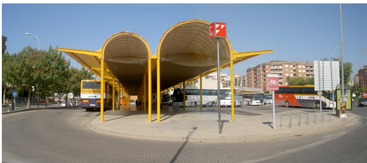
Imatge 4.3.12 Vista general de l'estació d'autobusos (I).
