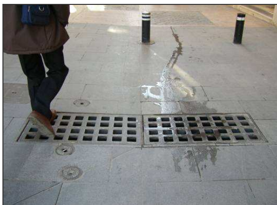
Imatge 4.1.26 Reixa de clavegueram amb obertures de 7,3 cm a la plaça del Mercadal.
