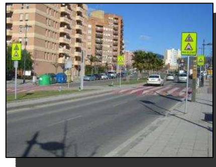
Pas de vianants de ressalt a l'av. Marià Fortuny
