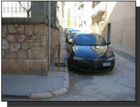
Vorera al c/Sardà. Absència de pas de vianants o voreres rebaixades
