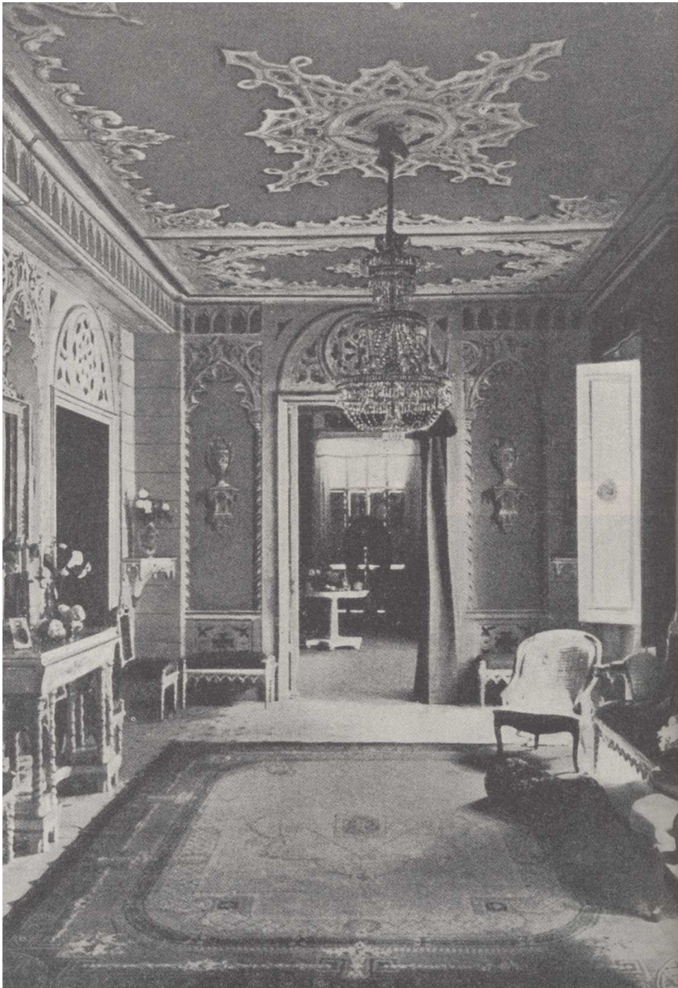
Una de les cambres de Ca Gai, al carrer de Prat de la Riba, cap als anys vint. En plena guerra Civil, s'hi començà a instal·lar el nou Museu Comarcal de Reus.
