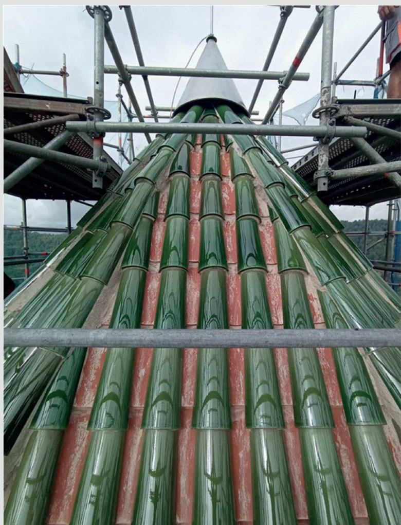
Rehabilitació del portal de l'assumpta. Monestir de Santes Creus.
